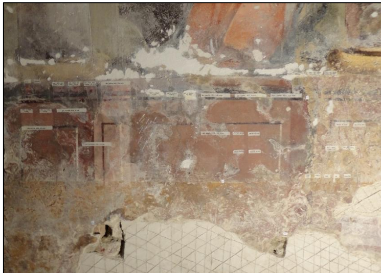
Slika 6. Mjesta izvedenih probi na sjevernom zidu kapele Muke Kristove
