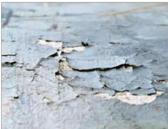
Slika 5. Brodogradilište , nepoznatog autora, 20. st., ulje na platnu, privatno vlasništvo, detalj slike. Nedostaci i oštećenja u sloju osnove i boje. Izvor: diplomski rad Lare Kreš (2014.). Autorica fotografije: Lara Kreš (2013.).
