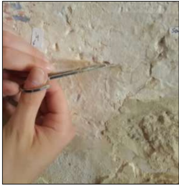
Slika 2. Parcijalno uklanjanje jap. papira
