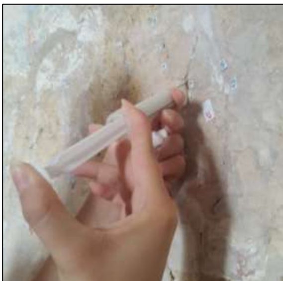
Slika 3. Ispunjavanje šupljina smjesom PLM-AL
