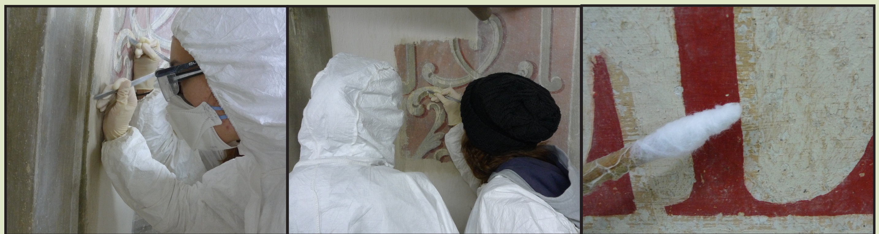
Slika 4. Uklanjanje naliča mehanički i destiliranom vodom
